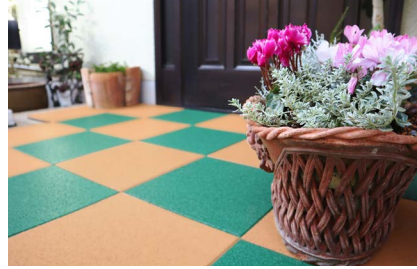
施工事例：玄関ポーチ
